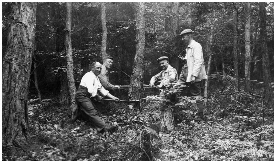
Beim Arbeitsdienst für die Erweiterung der Hütte 1925. Bei den Baumfällarbeiten zu erkennen Peter Schönung (links), Heinrich Primavessy (2.v.r.), Edmuard Garske (rechts)
